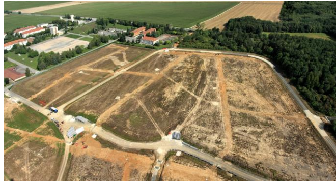
Terrain avant le début des travaux
