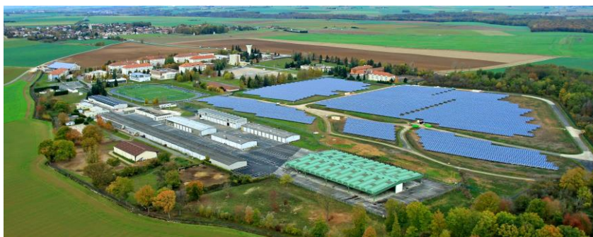
Installation à la fin des travaux
