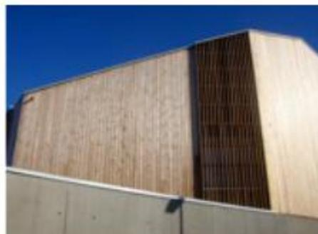
Une paroi translucide Nord ainsi qu'un sheed apporte un éclairage sans éblouissement dans la salle omnisport. La contre-pente du sheed orientée au Sud comporte des capteurs photovoltaïques souples dont la production d'électricité est réinjectée sur le réseau et revendu à EDF.
