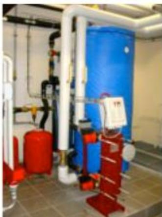
Le chauffage et la ventilation des vestiaires - sanitaires et douches sont réalisés au moyen de radiateurs et de deux centrales de traitement d'air à double flux comportant seulement un récupérateur à plaques.
