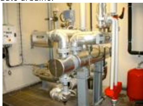
Nous avons donc une sous-station d'échange raccordée sur le réseau de chaleur capable d'alimenter les systèmes de chauffage et la distribution d'eau chaude sanitaire. Le tout étant sous le contrôle d'une gestion technique centralisée avec télécomptage.
